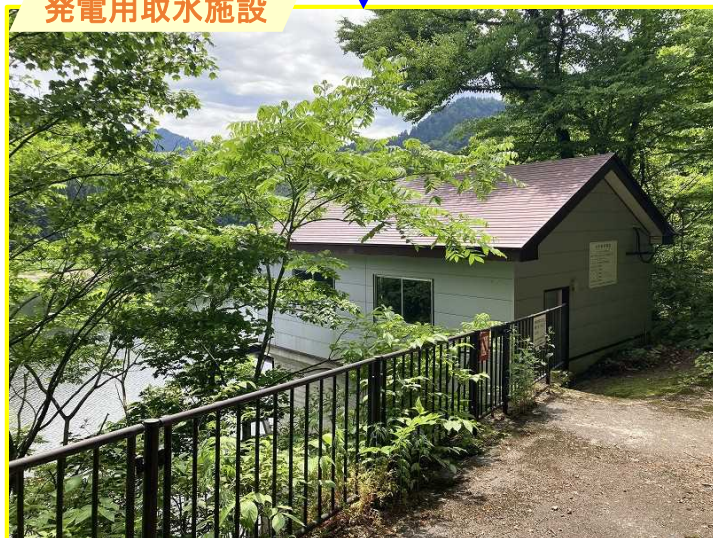
発電用取水施設
