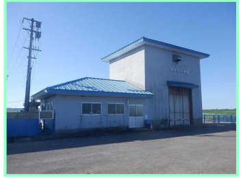
飯塚排水機場
