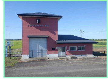
下虻川排水機場
