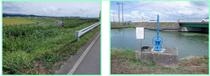
東部干拓第 3 工区承水路取水ゲート
