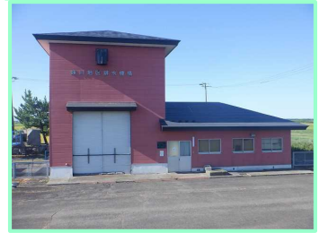
妹川排水機場
