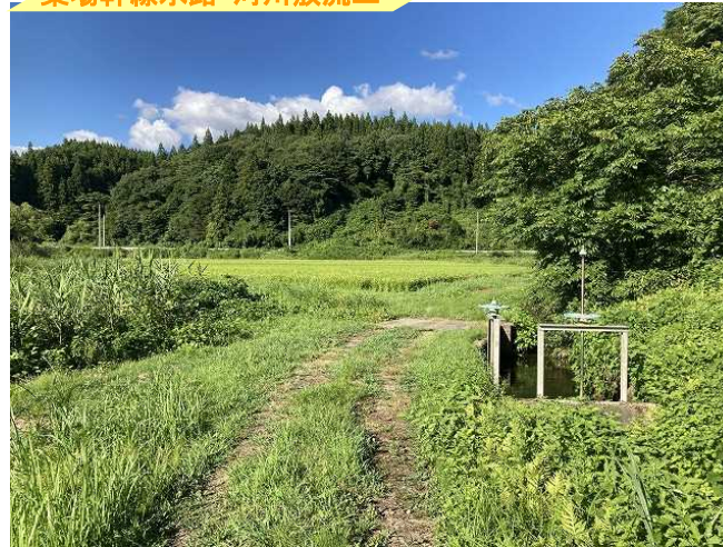
築場幹線水路 河川放流工
