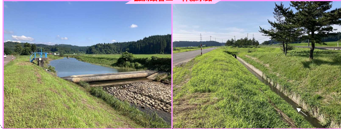
鵜渕頭首工・幹線水路
