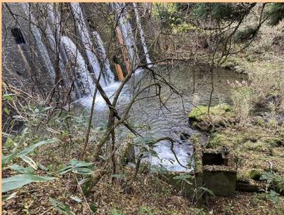
砂防堰堤の上部に取水口を設け、右岸側に流下。
