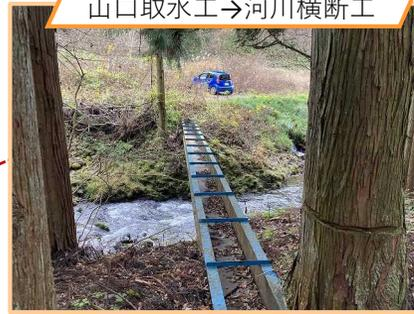
取水工下流側で右岸側・左岸側に分岐。左岸へは河川横断工により送水。
