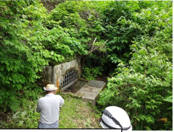
2号トンネル出口
