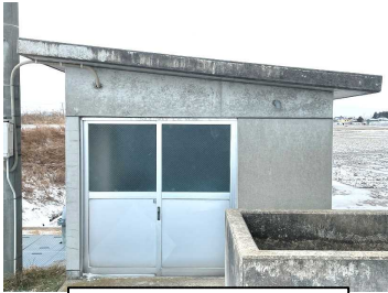
川向第1揚水機場
