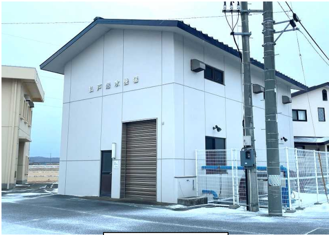
弘戸第1揚水機場
