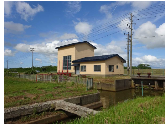
八西第1排水機場
