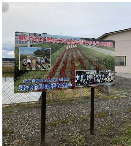
上谷地揚水機
