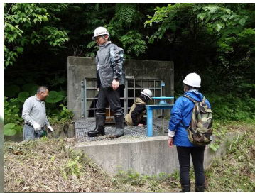
2号トンネル入口
