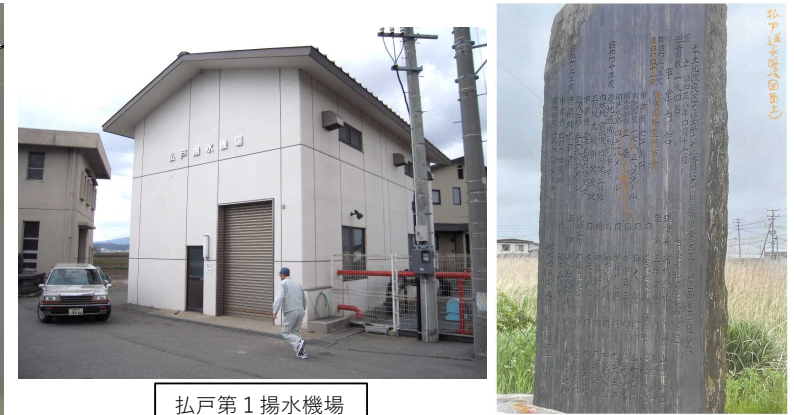
払戸第1揚水機場
