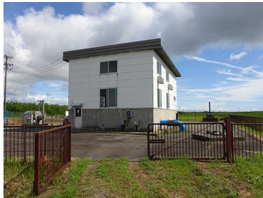
八西第1揚水機場
