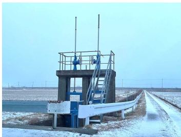
白城大排水取水ゲート 鋼製スライドゲート
