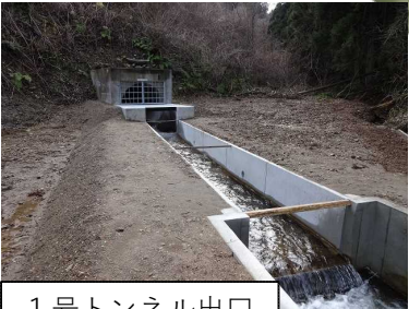
1号トンネル出口
