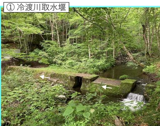
バー・スクリーン形式により右岸側で取水可能
