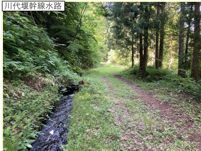
川代堰幹線水路と河川放流工
