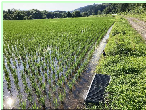
受益地・低圧管水路からの給水栓
