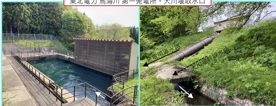
発電所ヘッドタンク・大川堰取水口
