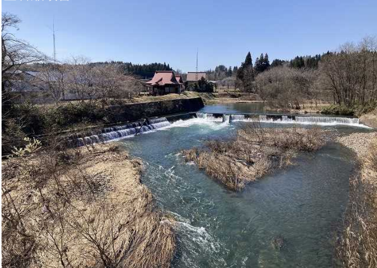
上岩瀬頭首工
