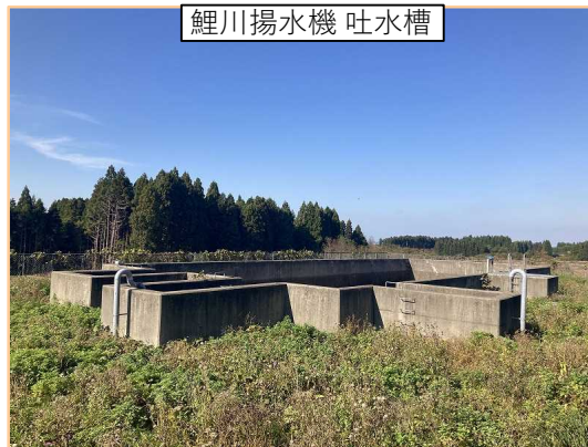
鯉川揚水機 吐水槽
