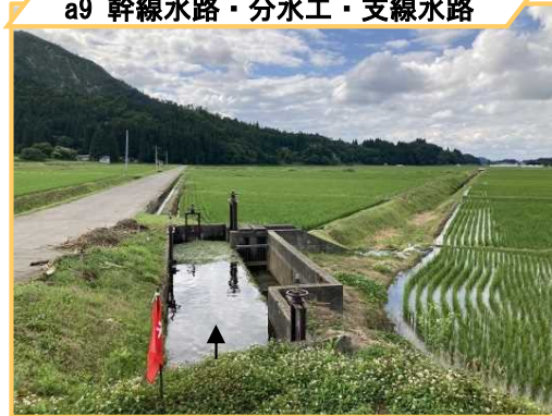
a9 幹線水路・分土工・支線水路
