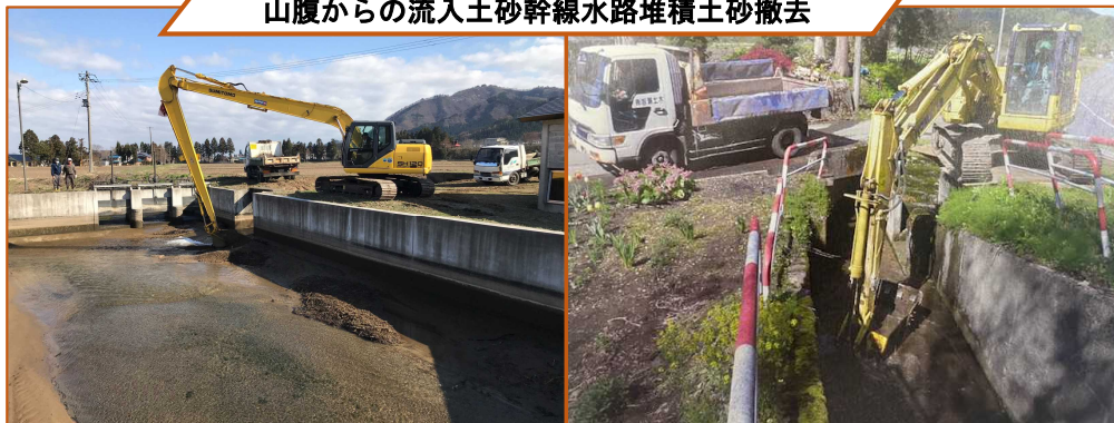
山腹からの流入土砂幹線水路堆積土砂撤去
