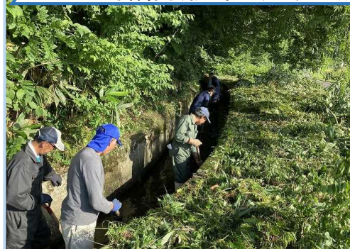
b5-4 5号幹線水路の草刈り・泥上げ
