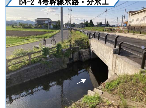
b4-2 4号幹線水路・分土工
