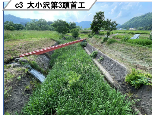
c3 大小沢第3頭首工
