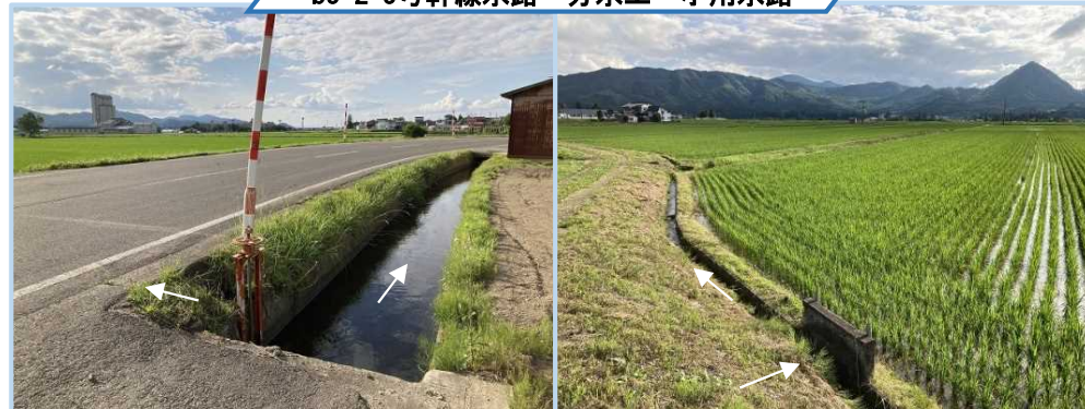
b5-2 5号幹線水路・分木工・小用水路
