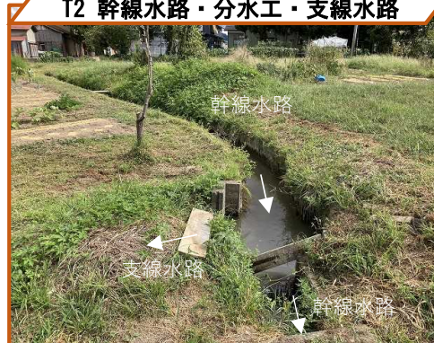
T2 幹線水路・分水工・支線水路
