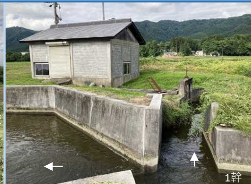
b2-3 2号幹線水路・河川放流工
