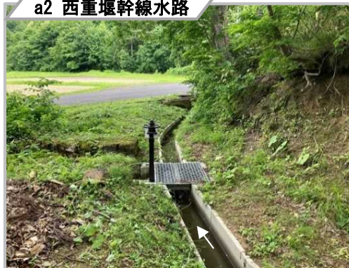
a2 西重堰幹線水路
