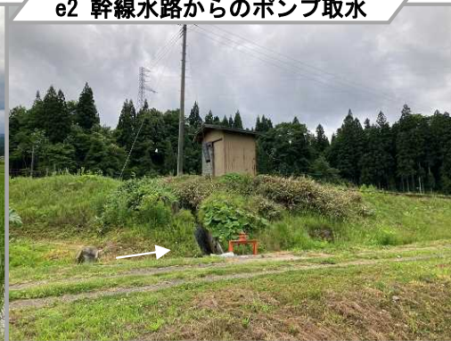
e2 幹線水路からのポンプ取水
