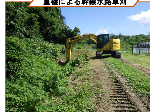
重機による幹線水路草刈
