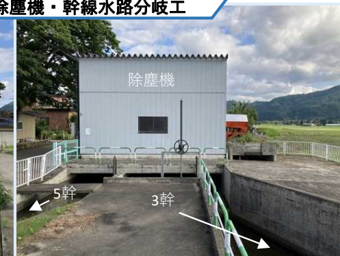
b2-6 2号幹線水路 除塵機・幹線水路分岐工
