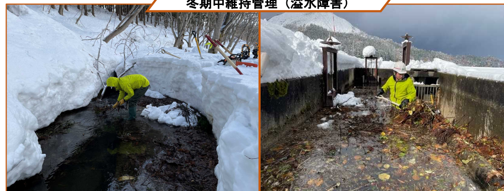
山腹からの流入土砂幹線水路堆積土砂撤去
