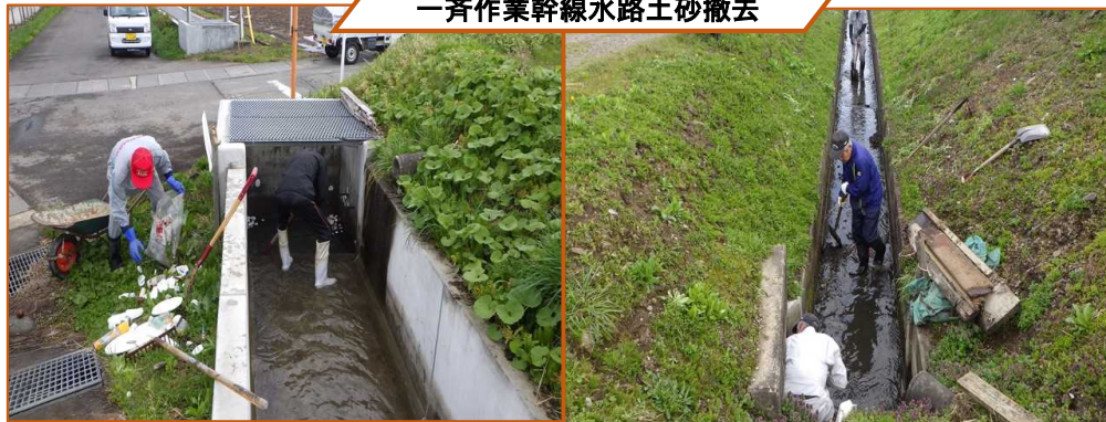
一斉作業幹線水路土砂撤去
