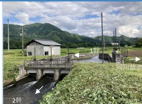
b2-2 2号幹線水路・分土工・支線水路
