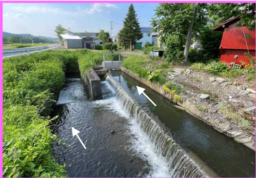
d1 大門開堰頭首工・幹線水路
