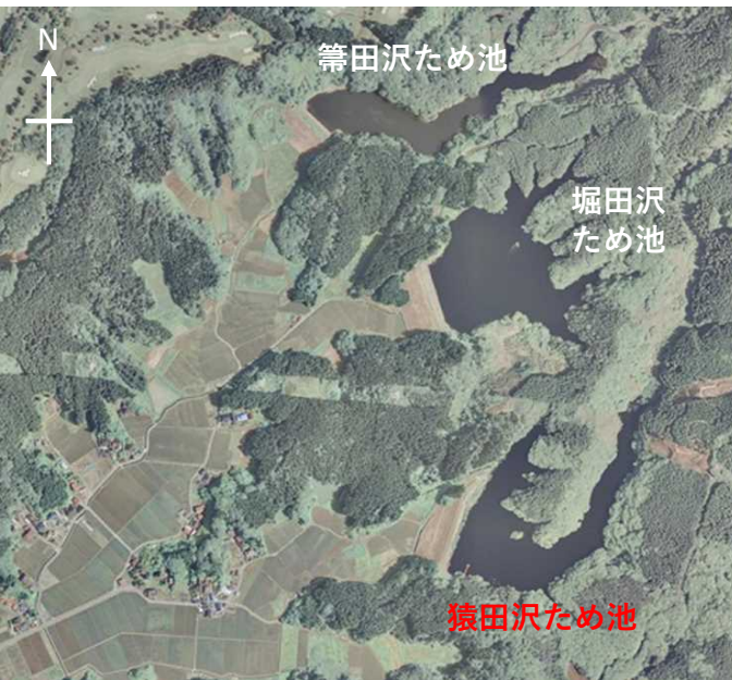
堤体・貯水池
