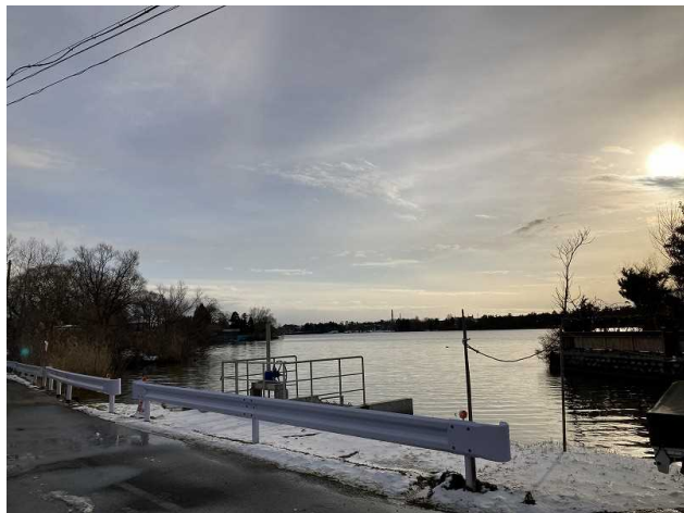
下刈揚水機場
