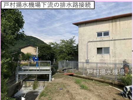
戸村揚水機場下流の排水路接続
