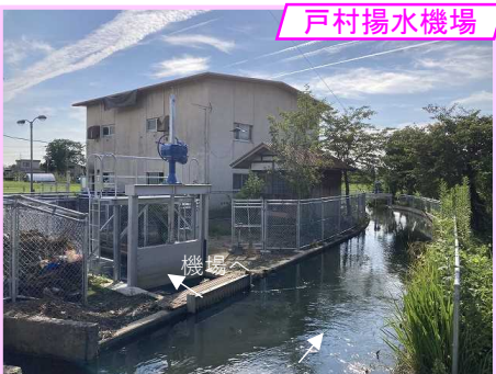
戸村揚水機場
