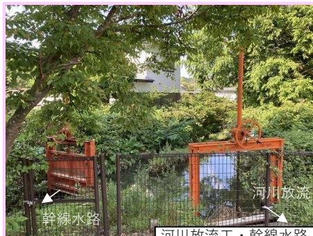
河川放流工・幹線水路
