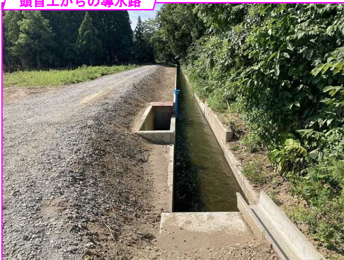
頭首工からの導水路
