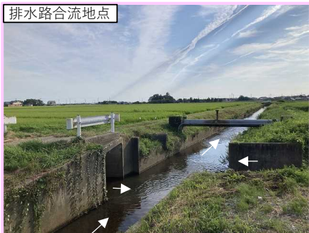
排水路合流地点
