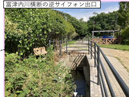
富津内川横断の逆サイフォン出口
