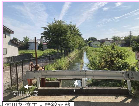
河川放流工・幹線水路
