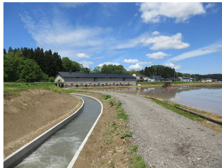
第1分水口の直下流：県営ストマネ事業での改修後
