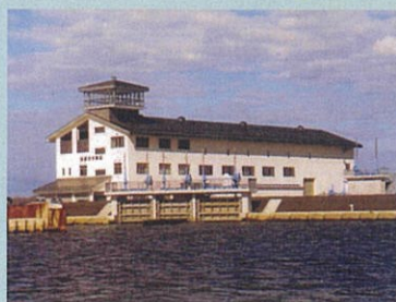
南部排水機場
