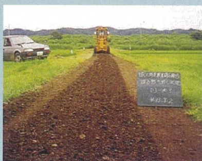
碎石敷き均し
