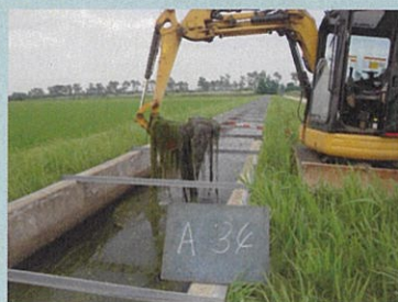
用水路内に繁茂した水草の除去
