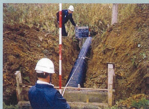
小用水路放水口補修状況
