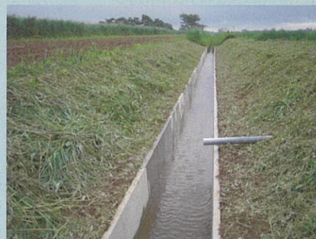
排水路更新（コンクリート水路）
