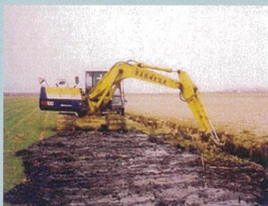
排水路埋め戻りによる掘削
