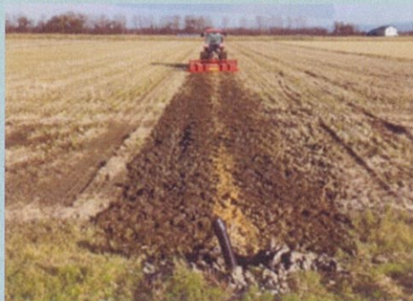
暗渠排水施工状況（農業者施工）
