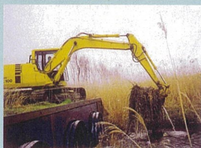
機械による排水路のゴミ上げ
