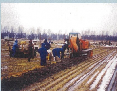
暗渠施工状況
