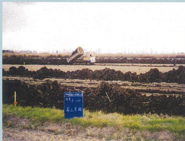
客土施工状況
