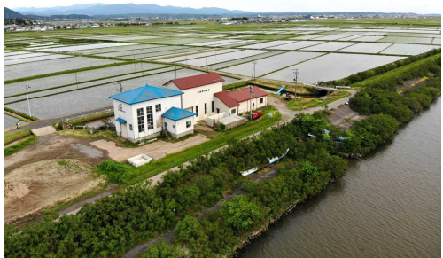
真坂揚排水機場
