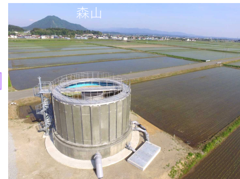
真坂高架水槽
