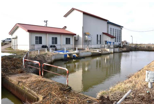
真坂揚排水機場
