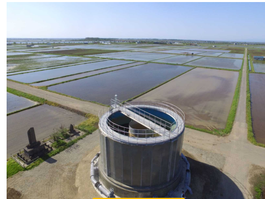
川口高架水槽
