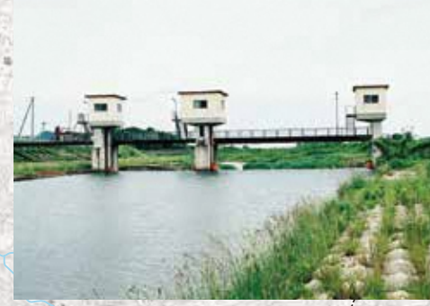
丸子州頭首工
