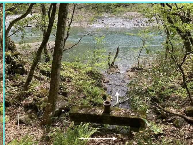
隧道下流部の山腹導水路部に設置された放流工
