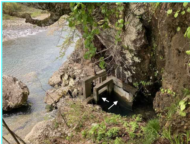
取水口の直下流に設けられた土砂吐と隧道部入口
