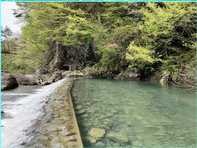
若松堰頭首工は固定堰であり右岸部から取水
