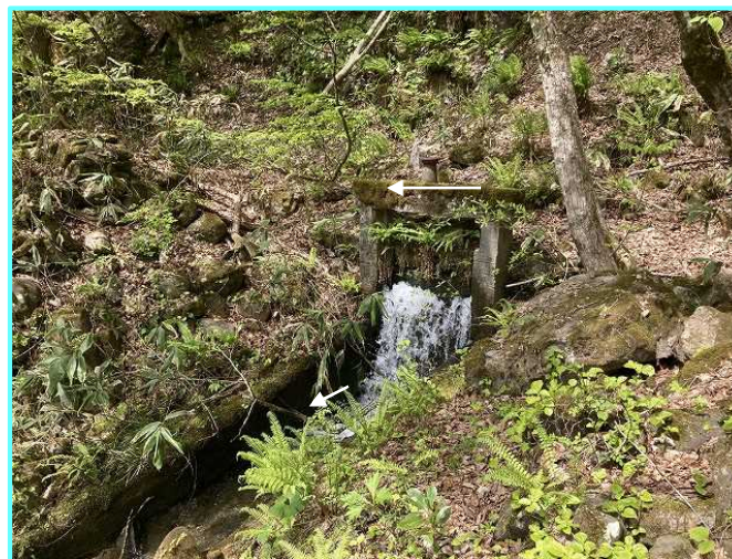
隧道下流部の山腹導水路部に設置された放流工
