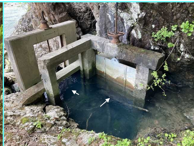
取水口の直下流に設けられた土砂吐と隧道部入口
