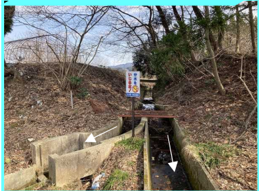
二田堰 導水路 (地区出口)
