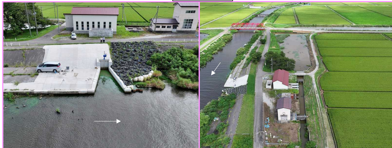
浜井川排水機場
