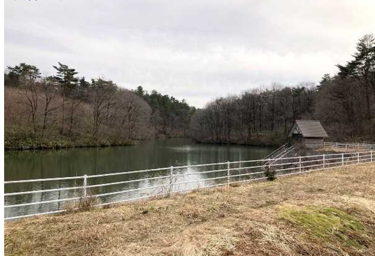
堤体・貯水池
