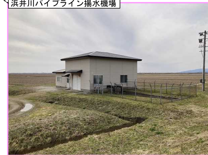
浜井川パイプライン揚水機場
