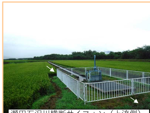
瀬田石沢川横断サイフォン（上流側）
