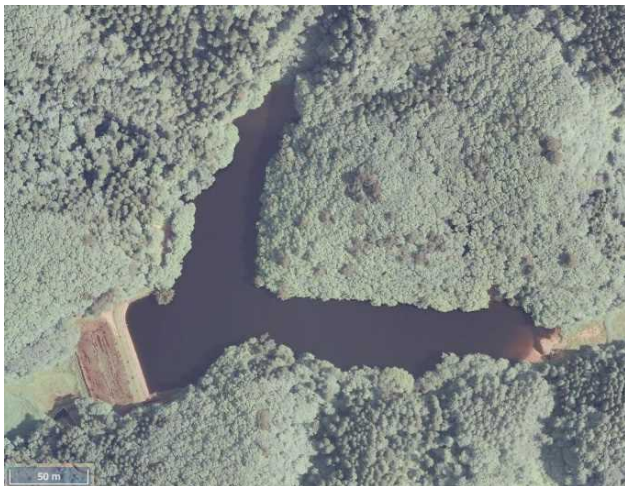
高井沢ため池
