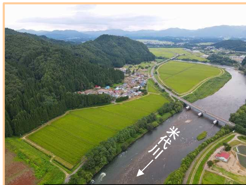
米代川右岸下流部から上流を望む
