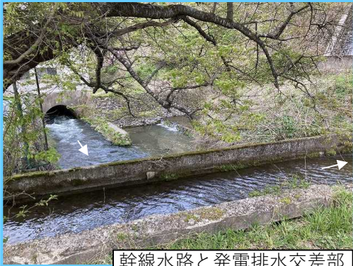
幹線水路と発電排水交差部
