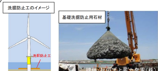
図64 基礎洗掘防止工
