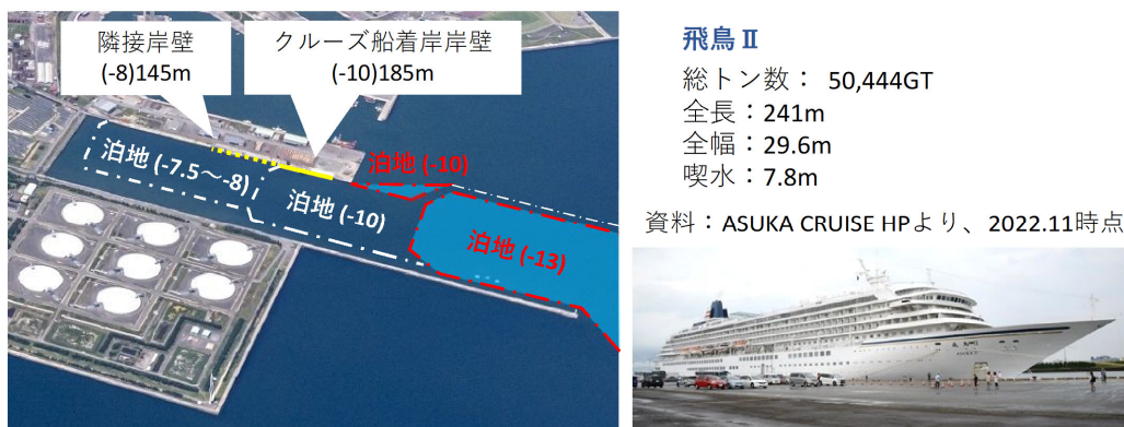
図44 クルーズ船の着岸岸壁
