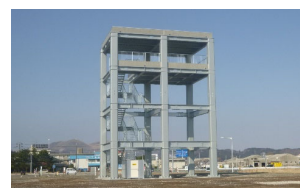
図53 津波避難施設
