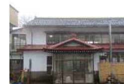
古民家のゲストハウス整備
