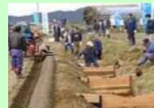
集落総出で魚道を設置
