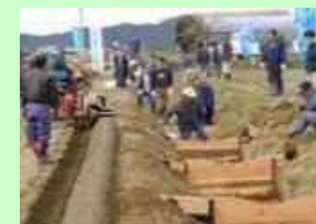
集落総出で魚道を設置
