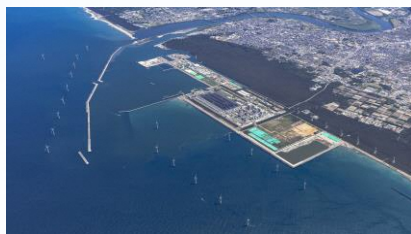
【能代港ふ頭用地造成事業】 洋上風力発電の拠点の形成に向けた港湾整備
