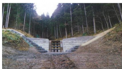
【通常砂防事業】 気候変動に伴う土石流被害の軽減を図る砂防堰堤等の整備
