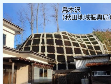
【急傾斜地崩壊対策事業】
