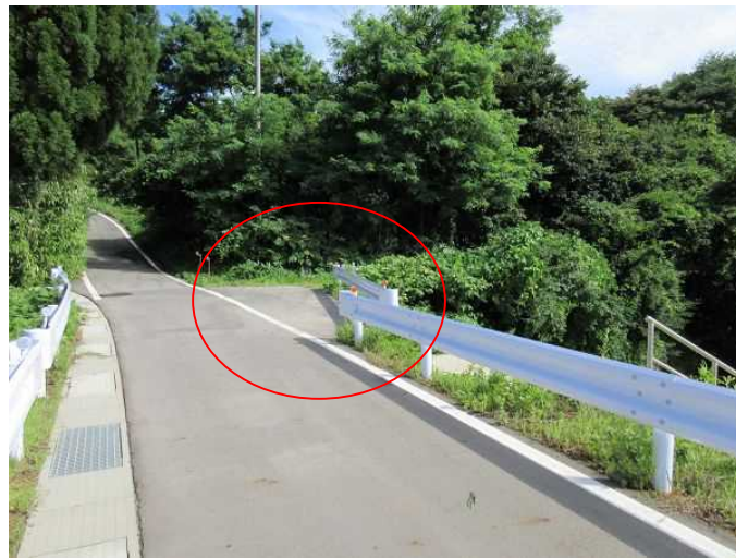
現地調査写真
