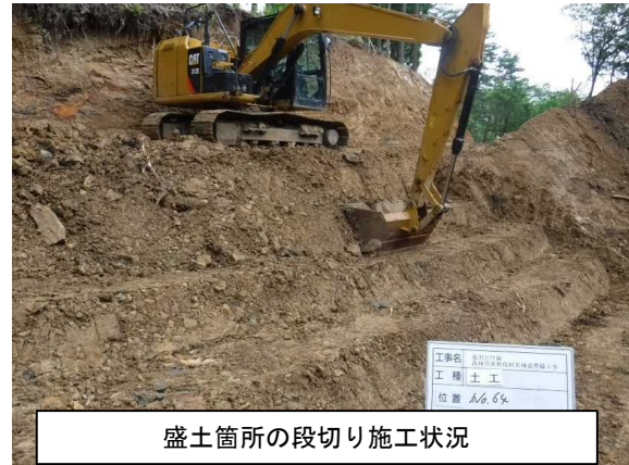
狭隘な施工条件下での掘削状況
