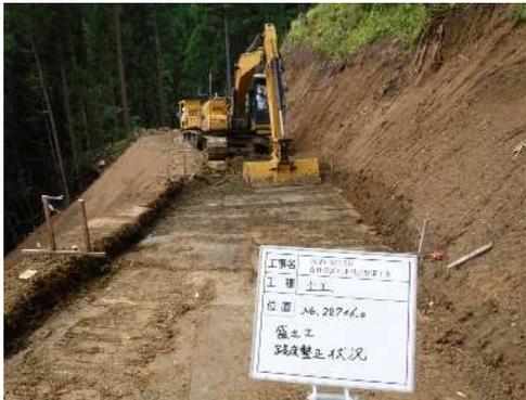
狭隘な施工条件下での路床構築
