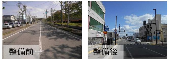
病院へアクセスする道路において、電柱倒壊等のリスクを解消するため無電柱化
