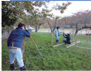
▲ 「やり方」と呼ばれる、住宅の基礎を設置するための重要な作業の様子です。
