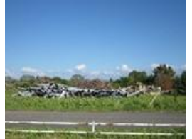
撤去物集積状況
