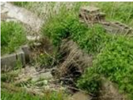
施設用地内で確認された コンクリート構造物
