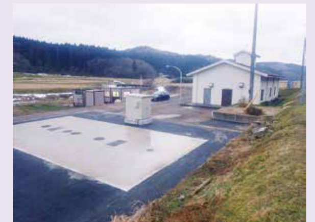
農業集落排水施設の改修
