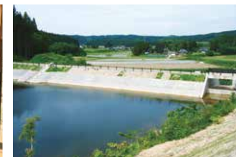
防災重点農業用ため池
