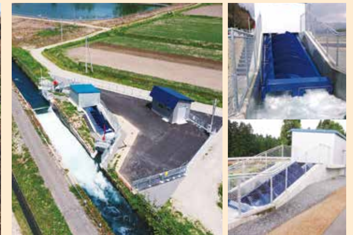
農業水利施設を活用した小水力発電(らせん水車型)
