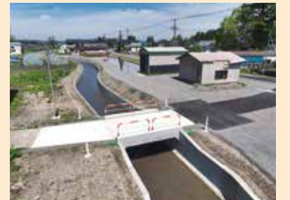
蛭野・角間川堰地区 (かんがい排水事業)
