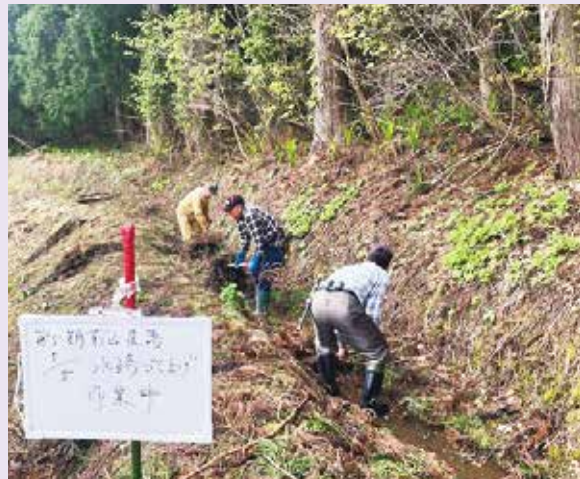
水路の土砂上げ
