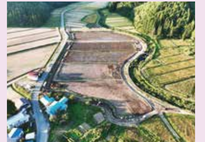
上院内地区 (中山間地域のほ場整備事業)
