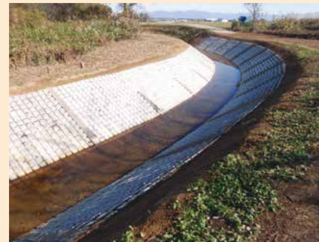
基幹的農業水利施設の補修
