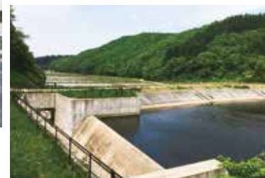
防災重点農業用ため池
