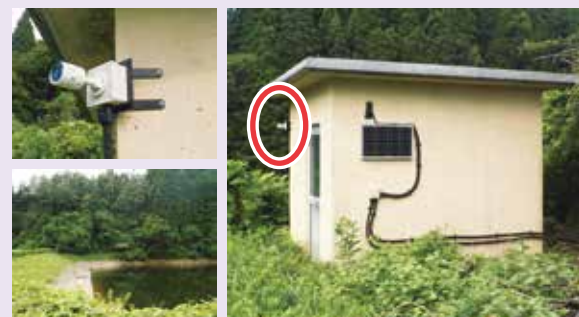
カメラによるため池の遠方監視
