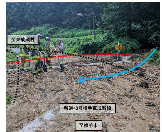
〔土砂流出（横手市除キ）〕
