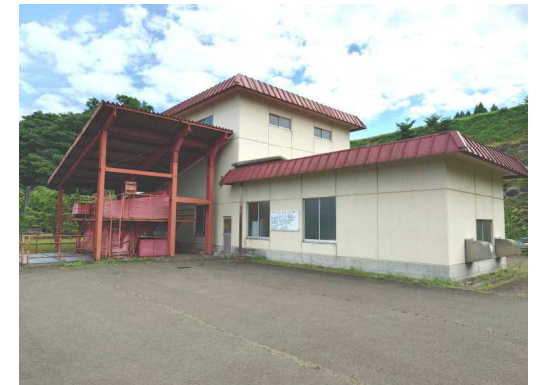
〔鷹巣三堰揚水機場（北秋田市）〕
