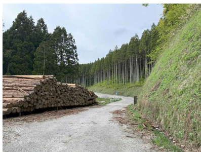
〔林道 峰浜線 八峰町〕 幅員 5.0m、開設延長 171m
