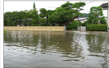
浸水被害（沼館地区）
