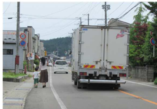
◆沖田面地区の現道状況
