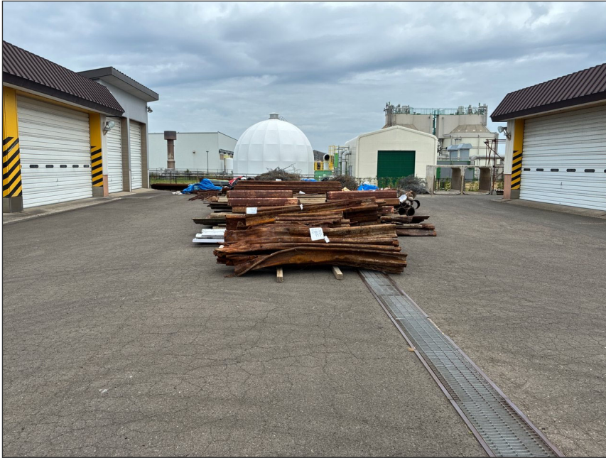
写真区分: 施工状況写真 工種: 構造物撤去工 種別: 運搬処理工 細別: 現場発生品運搬 写真タイトル: 向浜車庫 搬入全景
