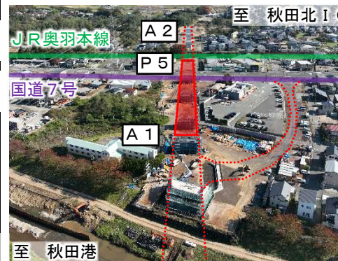
2号橋 (A1側より)
