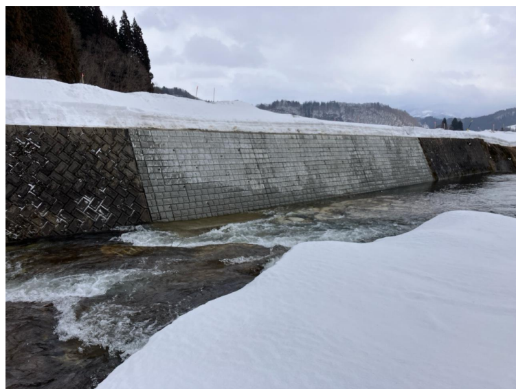
山ノ田沢川 県単砂防災害復旧工事
