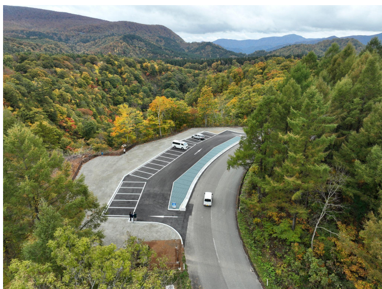
国道342号 県単道路補修工事（災害防除）
