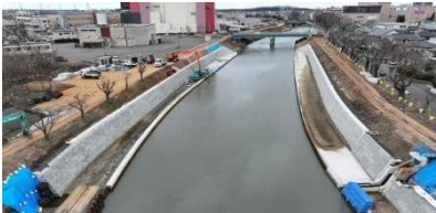
太平洋の治水対策工事
