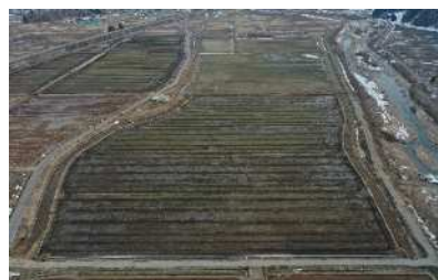
完成（用水・排水・道路工）
