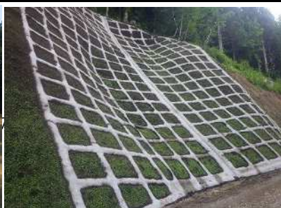
簡易法砕工完成
