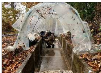
8号水路(雨水対策)
