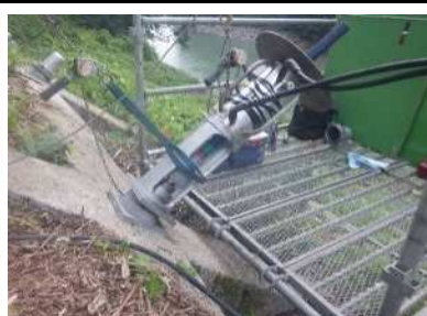
アンカー健全度調査実施状況
