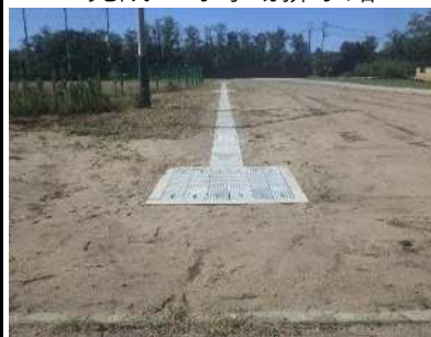
完成 野球場排水路
