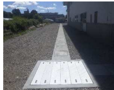
完成 流末排水路2
