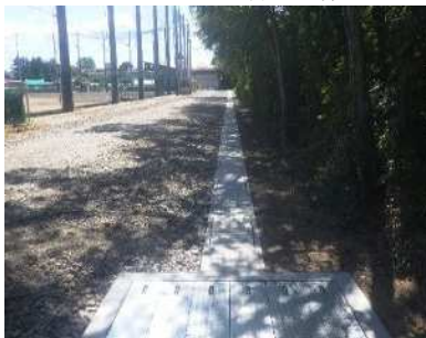
完成 流末排水路1
