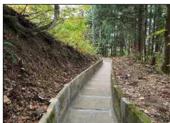
完成 8号水路(目地補修)
