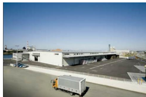
日本通運(株) (延床面積:8337.6㎡)
