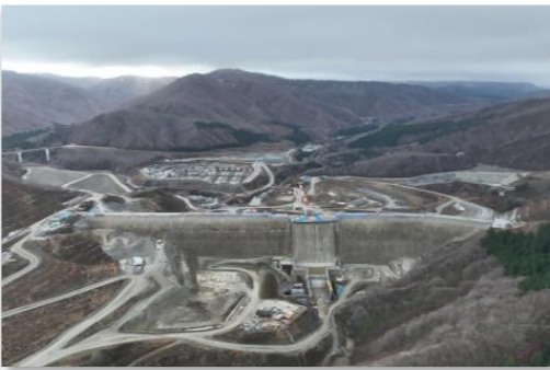
成瀬ダム（建設中） （成瀬ダム工事事務所 H P より）
