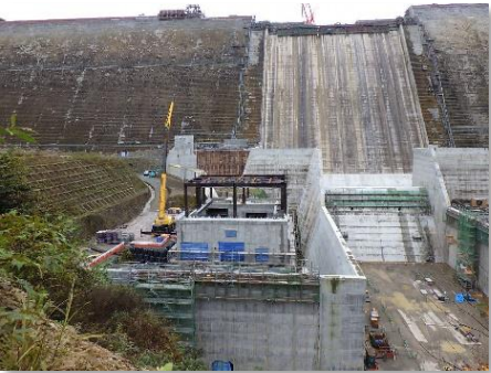
成瀬発電所（建設中）
