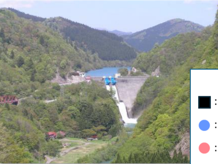
素波里発電所
