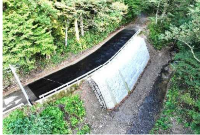
災害復旧工事
