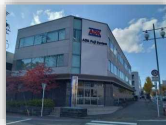
A社社屋改修工事
