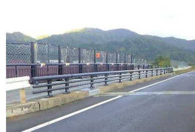
道路附属物補修工事
