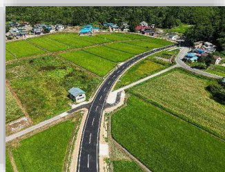
地方道路交付金工事
