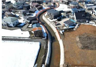
農業用水路整備工事
