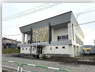
ふるさとふれあいセンター体育館改修工事
