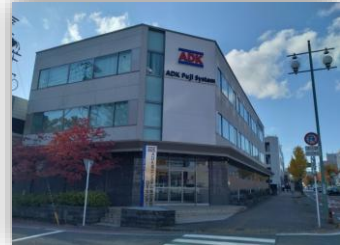
A社社屋改修工事
