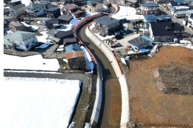
農業用水路整備工事
