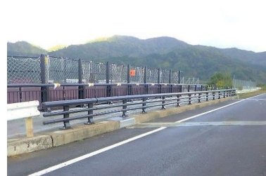
道路附属物補修工事
