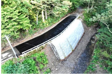
災害復旧工事
