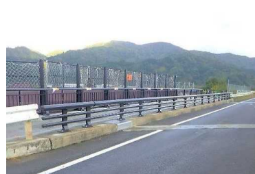
道路附属物補修工事
