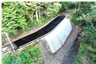
災害復旧工事
