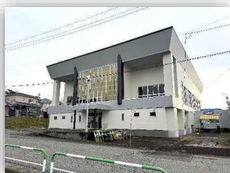
ふるさとふれあいセンター体育館改修工事
