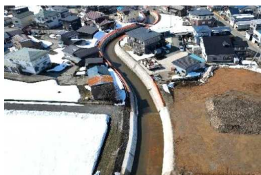
農業用水路整備工事
