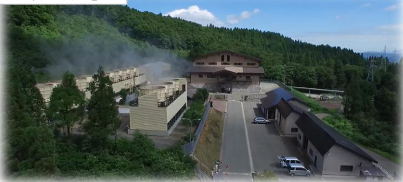
上の岱地熱発電所
