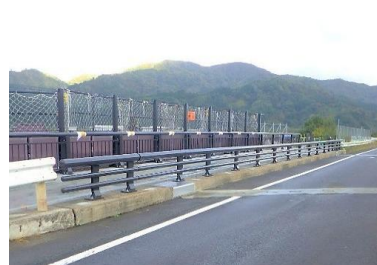
道路附属物補修工事
