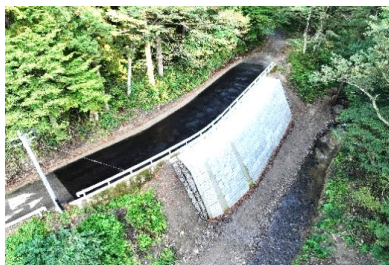
災害復旧工事
