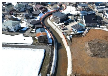
農業用水路整備工事
