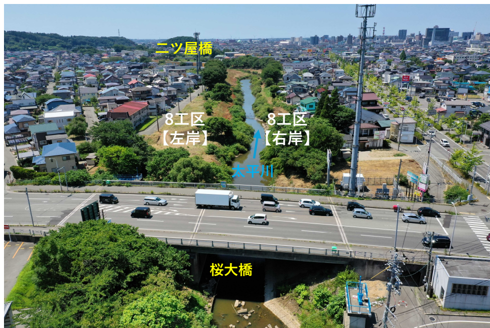
【写真①】 桜大橋の下流側 【着手前】
