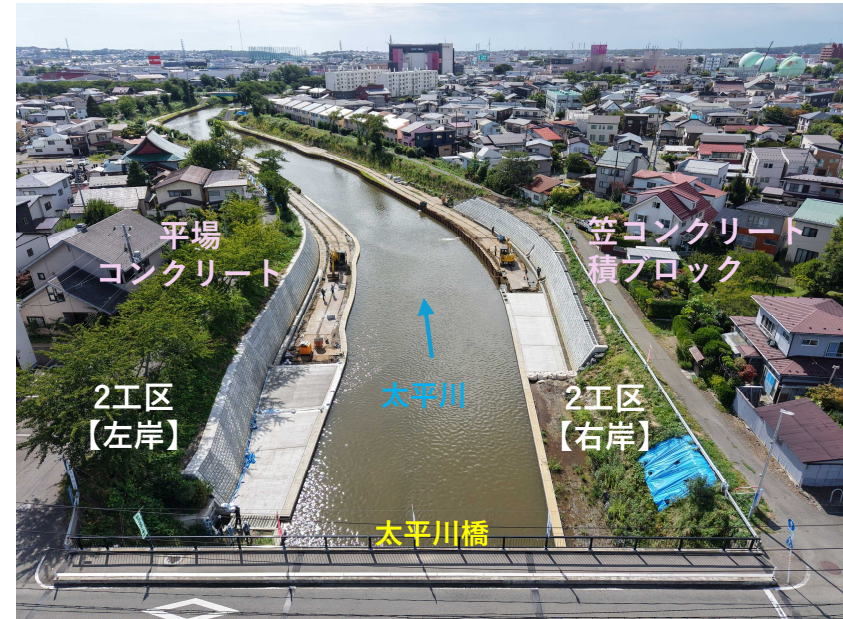
【写真②】 太平川橋の下流側【R8.8月撮影】
