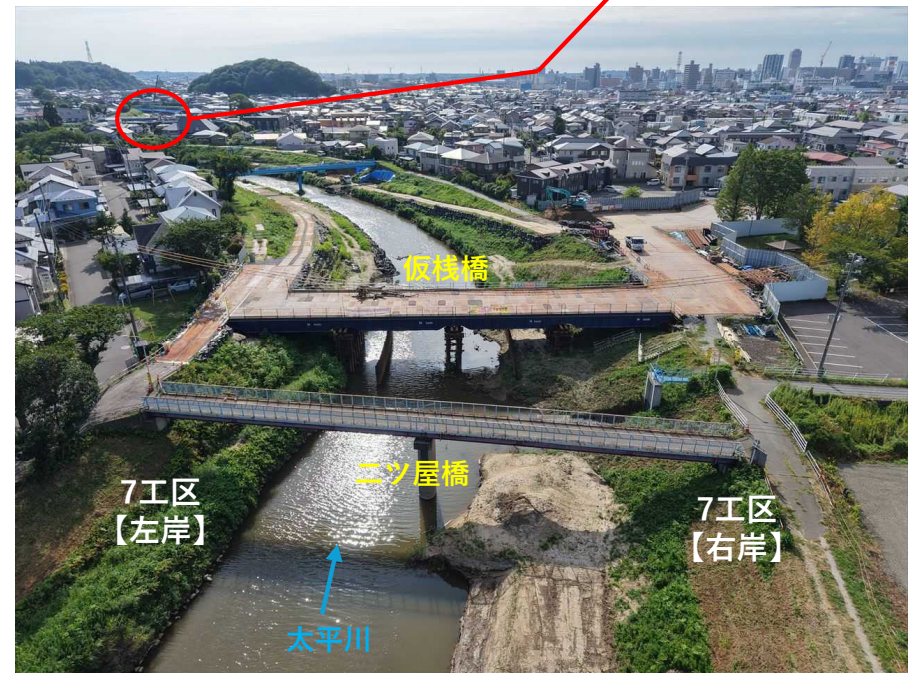
【写真②】ニツ屋橋の下流側 【R8.8月撮影】
