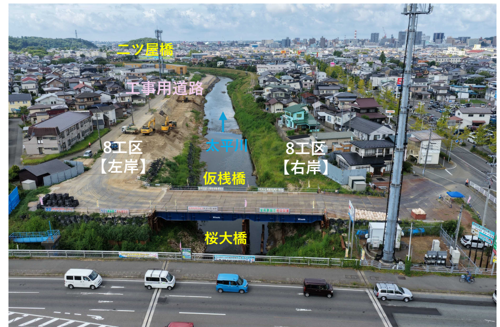
【写真②】 桜大橋の下流側 【R8.8月撮影】
