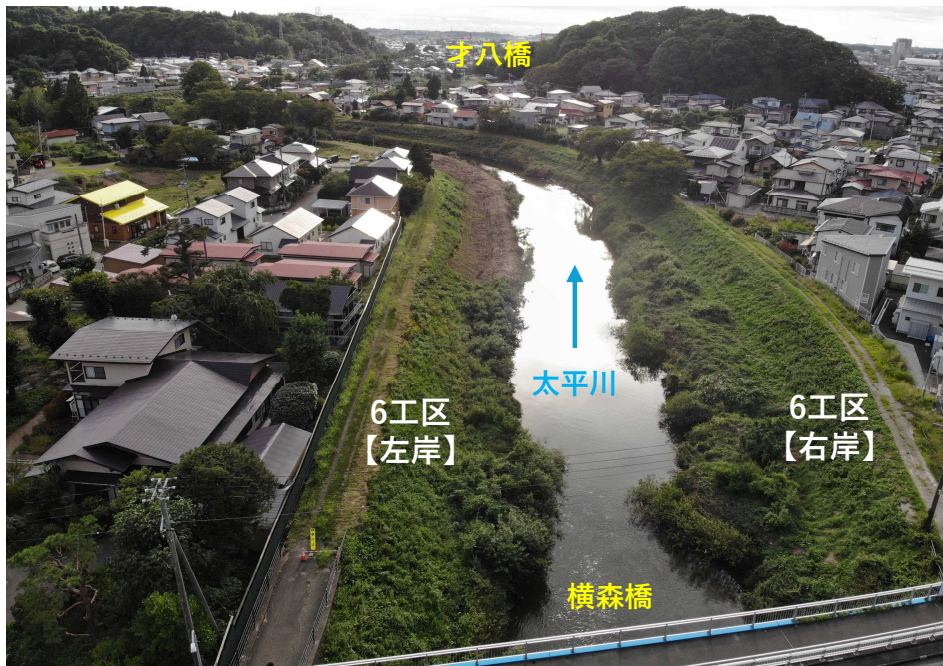
【写真①】 横森橋下流側 【着手前】
