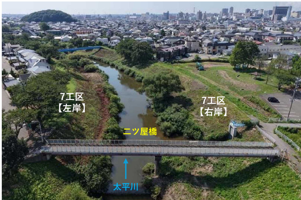
【写真①】ニツ屋橋の下流側 【着手前】
