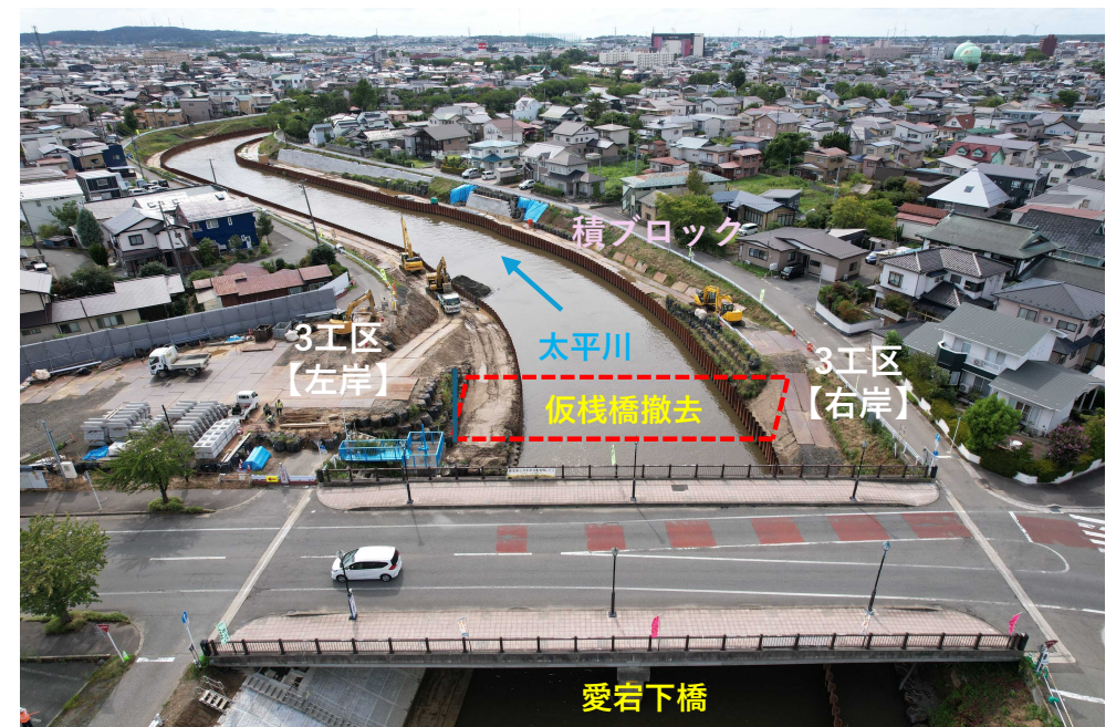
【写真②】 愛宕下橋の下流側【R8.8月撮影】
