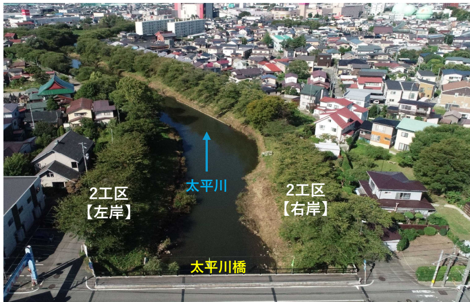
【写真①】 太平川橋の下流側【着手前】
