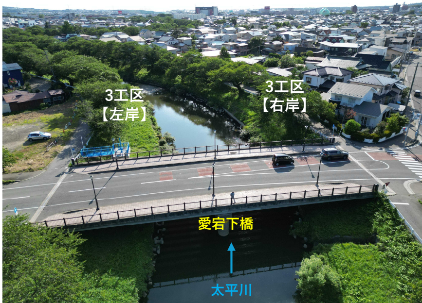
【写真①】 愛宕下橋の下流側【着手前】
